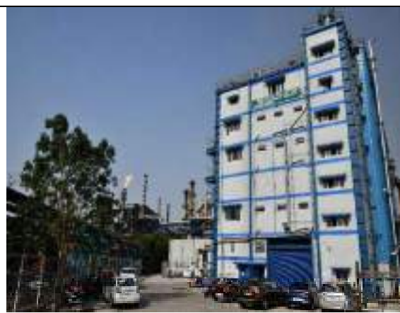
CDQ 40 MW Power Plant
