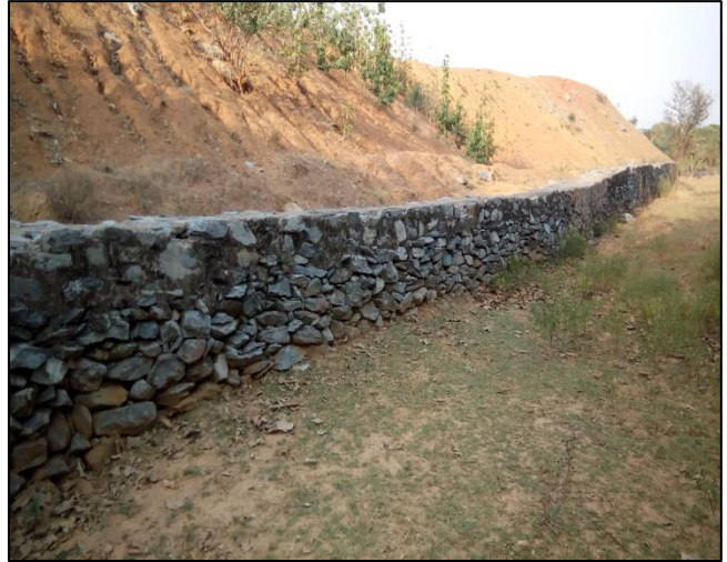
OB DUMP TOE WALL
